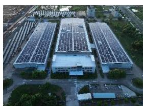
**Foto 3:** Im Miele-Werk im chinesischen Dongguan erzeugen 9.550 Solarpaneele pro Jahr 5.100 Megawattstunden Strom – mehr als genug, um das Werk vollständig mit Elektrizität zu versorgen. (Foto: Miele)
