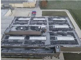
**Foto 2:** So groß wie sechs Tennisplätze: Auf einer Dachfläche von rund 4.000 Quadratmetern bilden mehr als 600 PV-Module ein kleines Sonnenkraftwerk am Miele-Standort in Warendorf. (Foto: Brockhaus Bedachungen)
