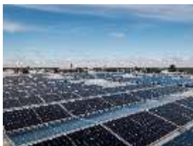
Foto 2: Die Photovoltaik-Anlage auf dem Dach der neuen Logistikhalle am Miele-Standort in Euskirchen besteht aus rund 900 PV-Modulen. Dank Sonnenkraft vom Dach und Erdwärme lassen sich jährlich rund 440 Tonnen Kohlendioxid einsparen. (Foto: Miele)
